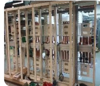
Fabricación de cuadros eléctricos
